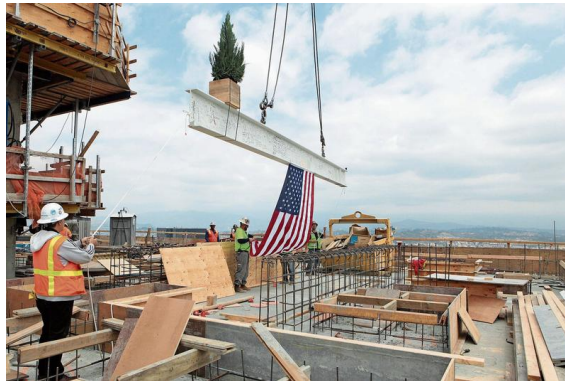
Der Arbeitsmarkt in den USA brummt, die Löhne steigen. (Los Angeles, 17. Mai 2017)
